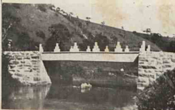
Ponte "Chacarinha" na estrada que liga os municipios de Parahyba do Sul e Valença, construida na administração do Dr. Virgilio A. Rodrigues.
